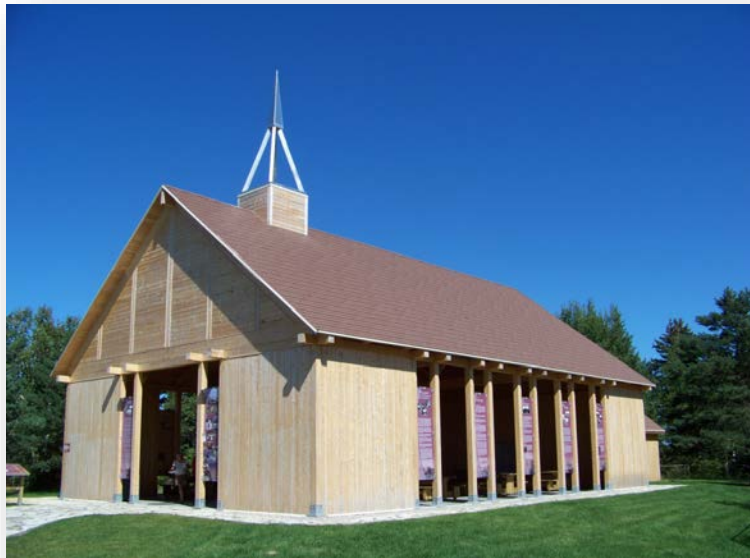
Abri de la chapelle du parc de la Pointe-des-Pères
